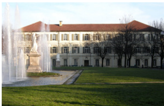
Figura 2 I'I.C. "Tommaseo", la facciata.
